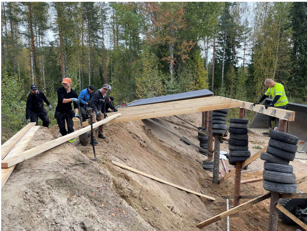
Pistooliradan toisen luotikatoksen rakennustyöt 24.9.2024.
