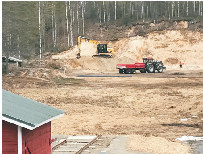
Vihtakankaan ampumaradalla suoritettiin mittavat maanvaihtotyöt.
