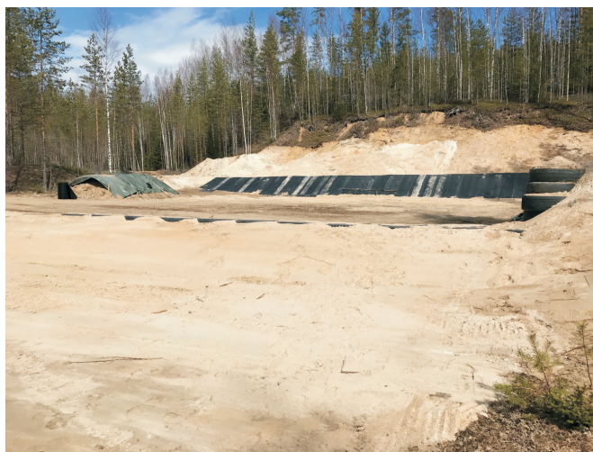
Ampumavallit suojattiin kumimatoilla.
